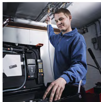
Kontrola rozvodu pitné vody a odpadního potrubí
