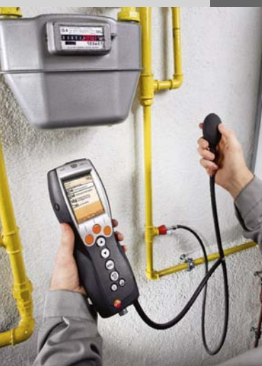
Kontrola plynového potrubí
