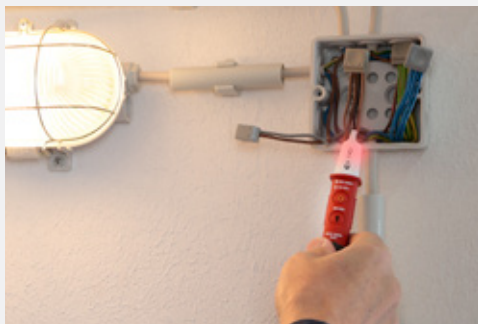
Rychlé odhalení problémů na vodičích s AC napětím
