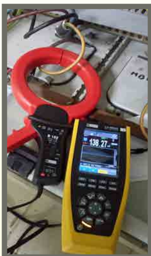
Měření unikajících proudů s možností záznamu poruchy
